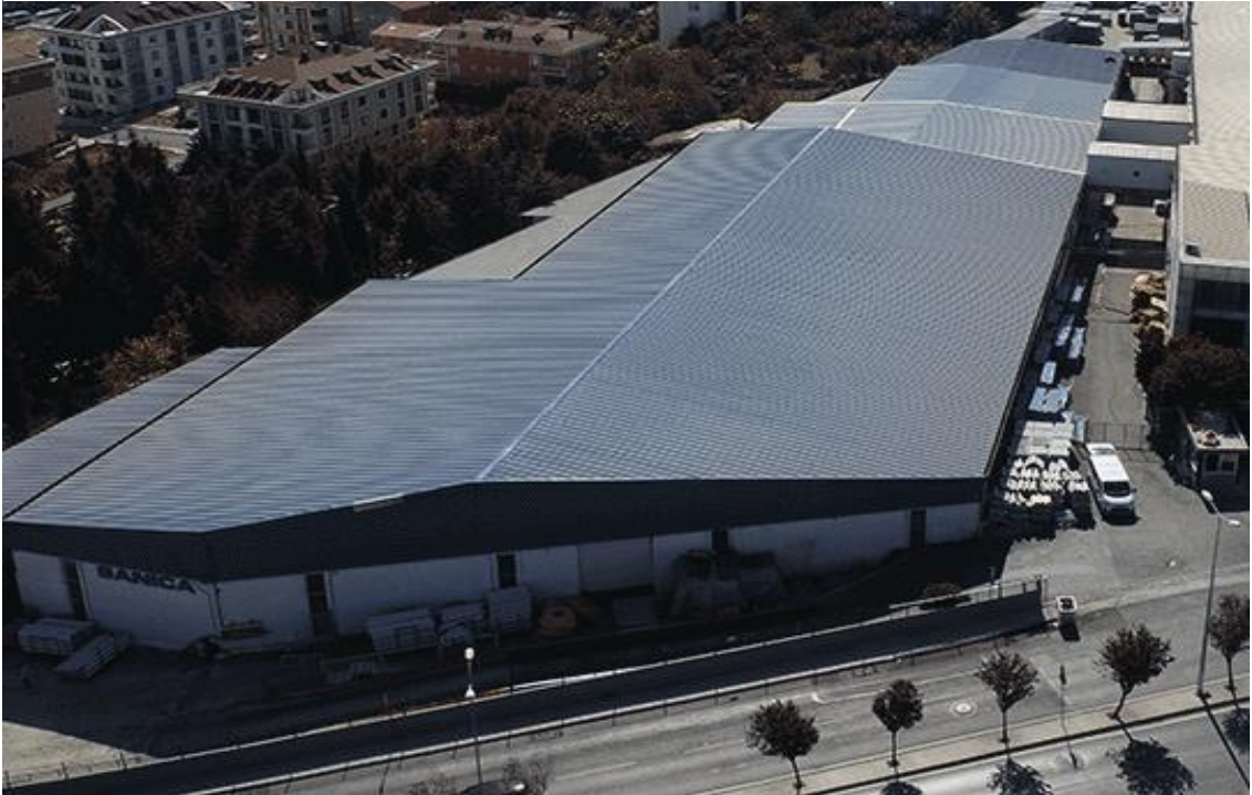
Şekil 4-3 İstanbul / Beylikdüzü Tesisi Genel Görünümü
